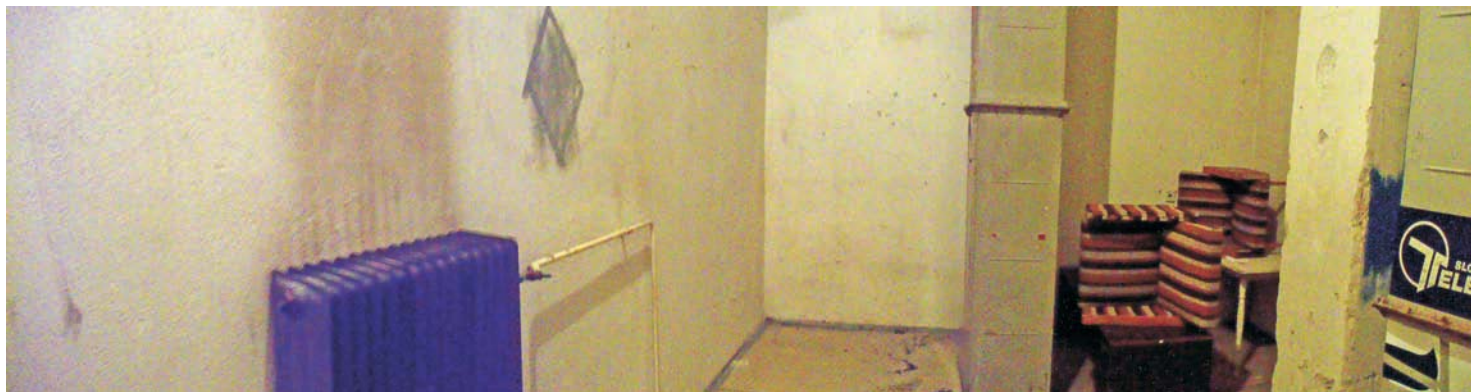
pôvodné nezrekonštruované priestory
